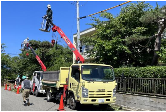
高所作業の様子
